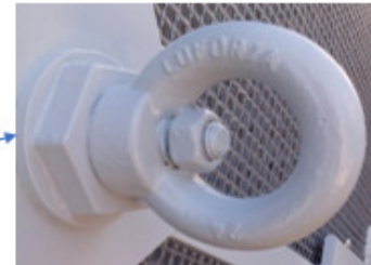
Detalhe do olhal de içamento da Cruzeta Superior e Cruzeta Inferior
