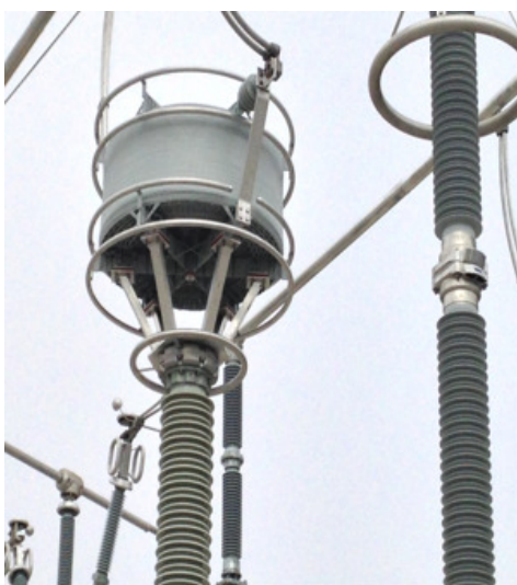
Montagem sobre 1 coluna de isolador
