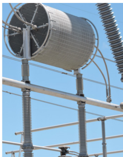
Montagem sobre 2 colunas de isoladores
