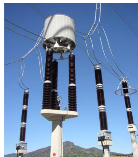
Montagem sobre 3 colunas de isoladores
