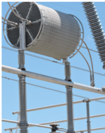
Assemblage sur 2 Isolateurs
