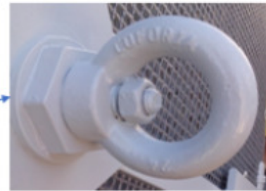
Détail del anneau de levage de la traverse supérieure et de la traverse inférieure
