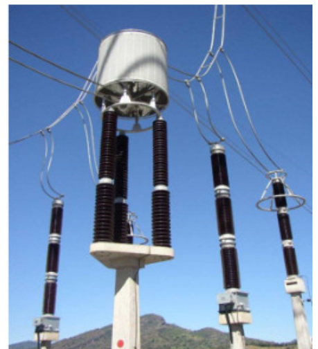
Assemblage sur 3 Isolateurs
