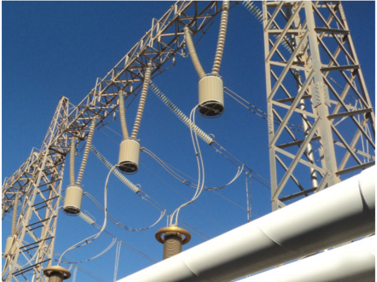
Assemblage en suspension
