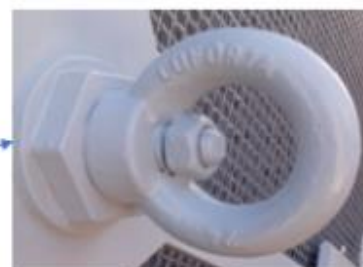
Detalle del cáncamo para izar de la cruceta superior y de la cruceta inferior
