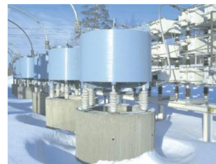
1.4 Высоковольтный фильтр подавления гармоник
